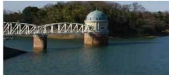
《貯水池にある取水塔》
