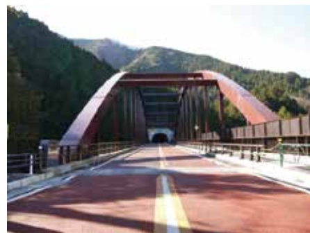
《道路整備 多摩川南岸道路(城山)》
