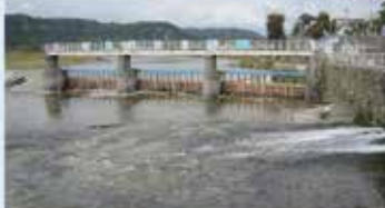
羽村取水堰（投渡堰）
