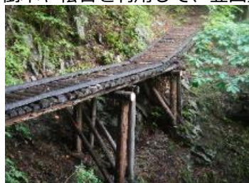
回廊の路 木橋の補修
