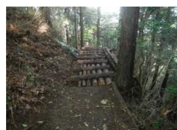
ブナの路 木橋の補修
