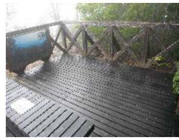
修繕後のテラス
