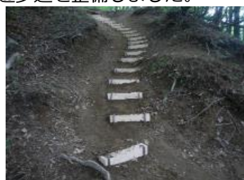
ブナの路 階段設置
