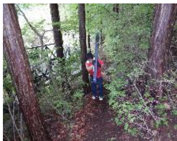
修繕の荷揚げの様子
