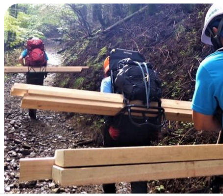
力を合わせて荷上げ作業
