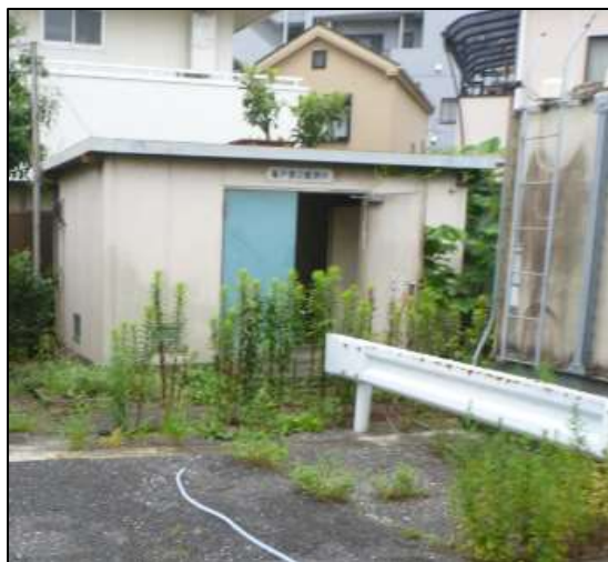
観測井の外観
