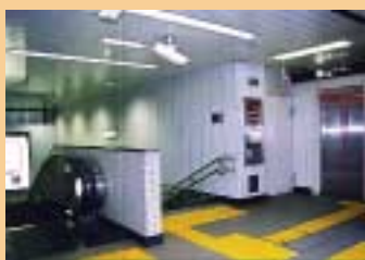
駅にエレベーター・エスカレーターを設置
