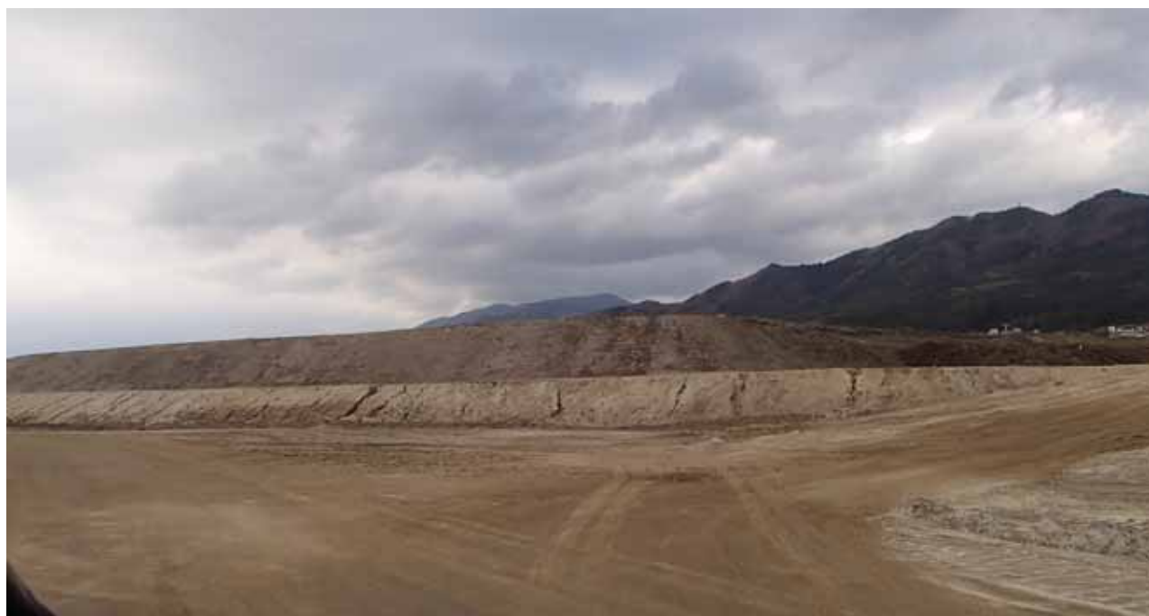
搬出終了時の仮置場の様子(平成 25 年 12 月 5 日撮影)
