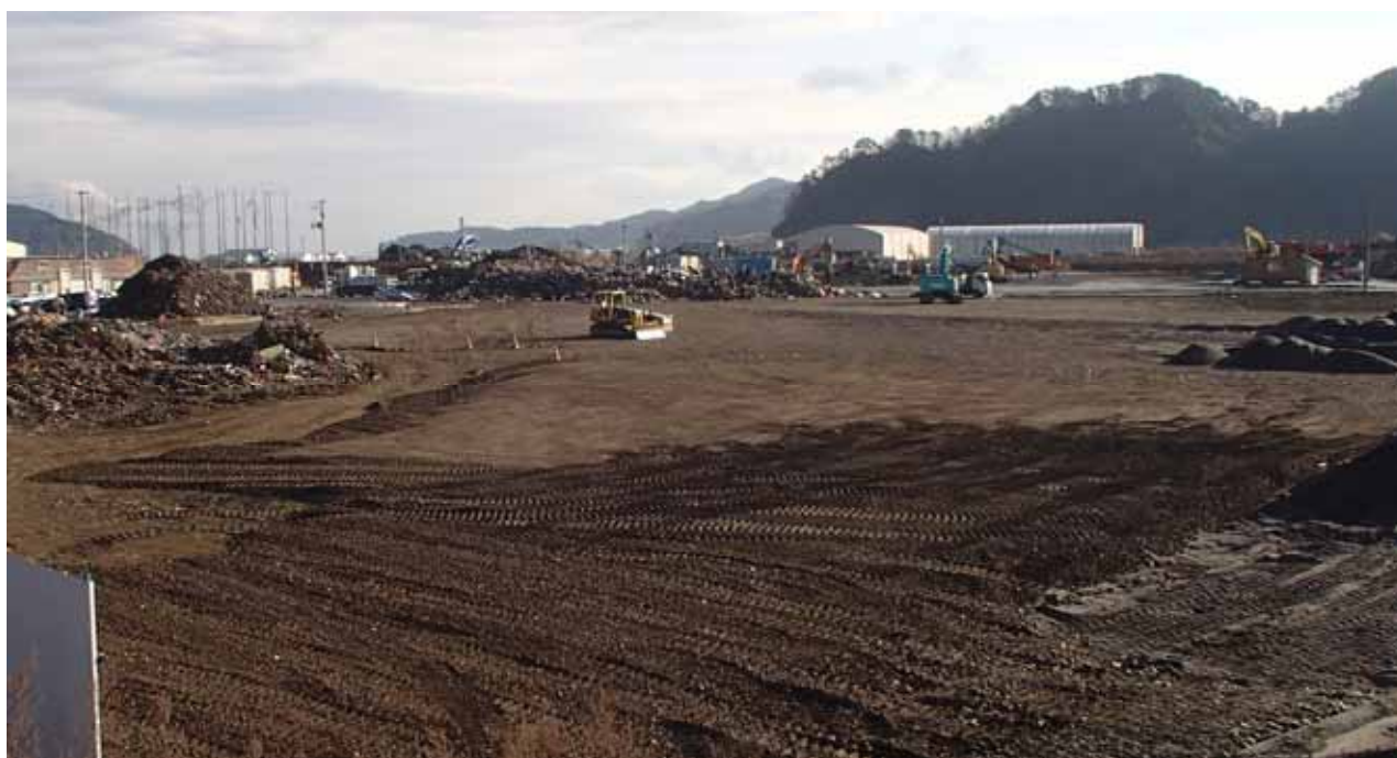
搬出終盤の仮置場の様子(平成 25 年 12 月 6 日撮影)
