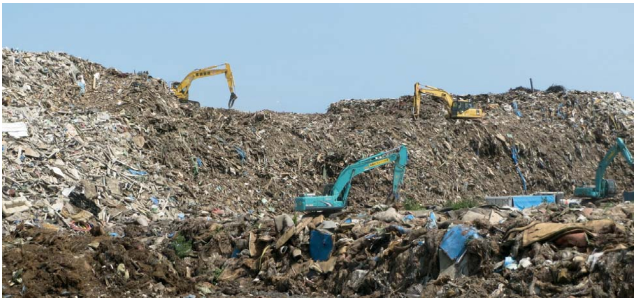
石巻市雲雀野埠頭仮置き場の状況（平成 24 年 7 月 19 日撮影）
