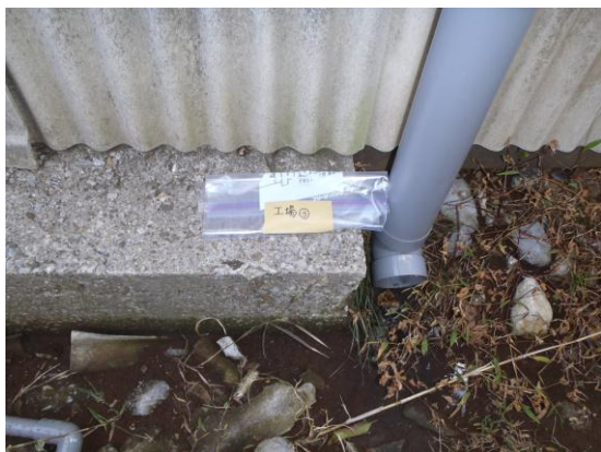
図3(1) 縦樋の下の土壌での濃集(蓄積)
