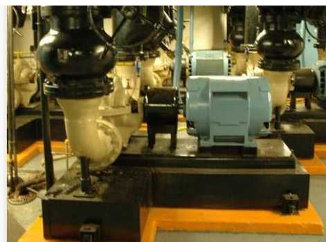
チラープラント改修
