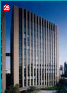
26 Eitai Dia Building 14-5, Eitai 1-chome, Koto-ku
