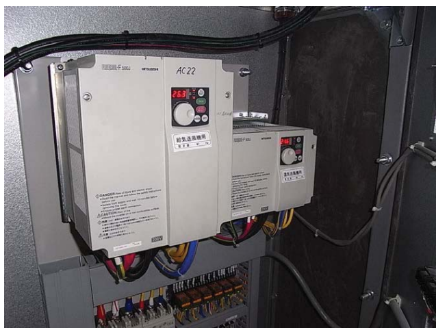
インバータ本体(インバータ盤内部)
