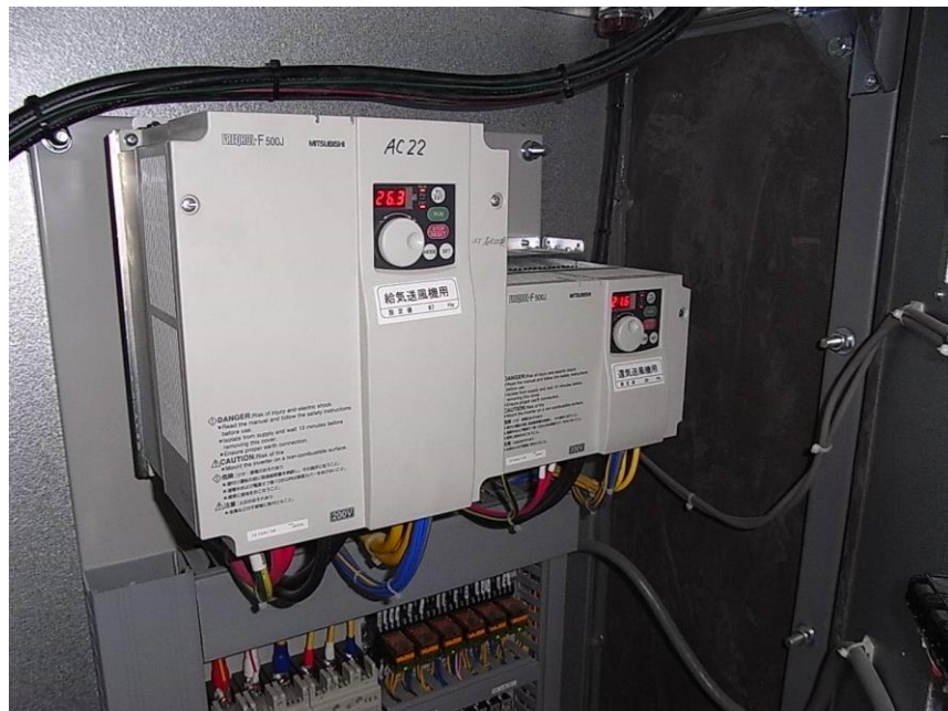
インバータ本体（インバータ盤内部）
