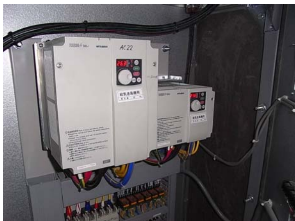
インバータ本体(インバータ盤内部)
