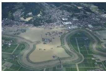
2021年8月大雨 佐賀県など 国土地理院HPより引用
