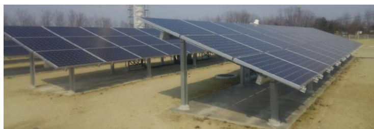
電解用太陽電池 20kW
