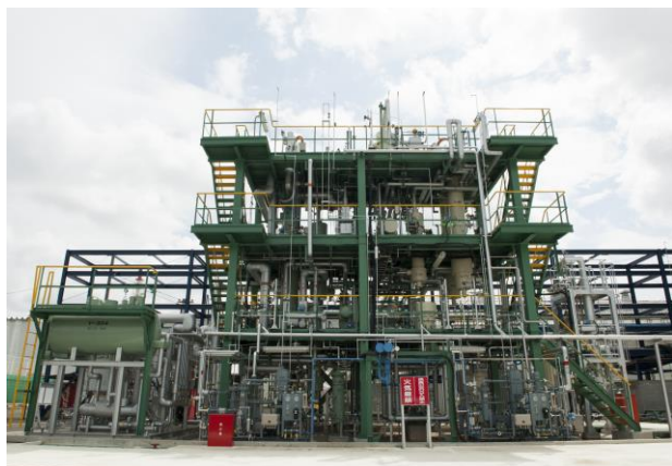
実証プラント
