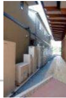
水素燃料電池実証住宅 燃料電池 (1kW級×7)
