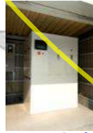
低圧水素 充填装置
