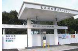
北九州水素ST NEDO JHFC3 ②地域実証研究
