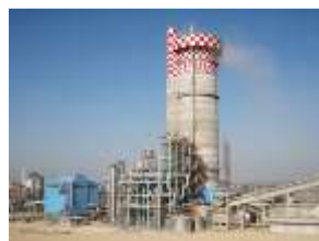
肥料プラント (水素大量製造)
