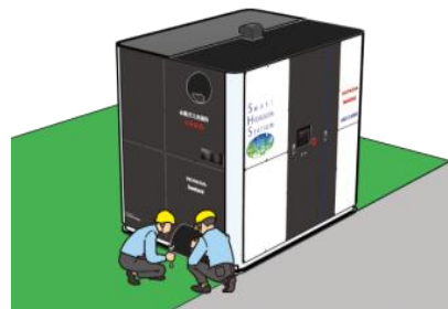
5. 配管工事（水・電気を接続）
