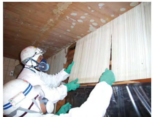
▼アスベスト除去作業
