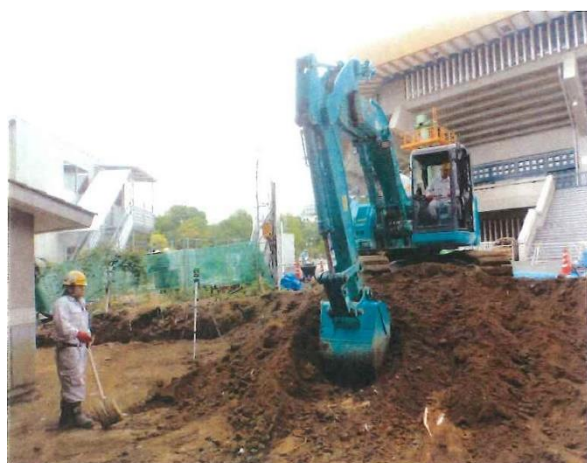
写真-1 汚染土壤の掘削除去
