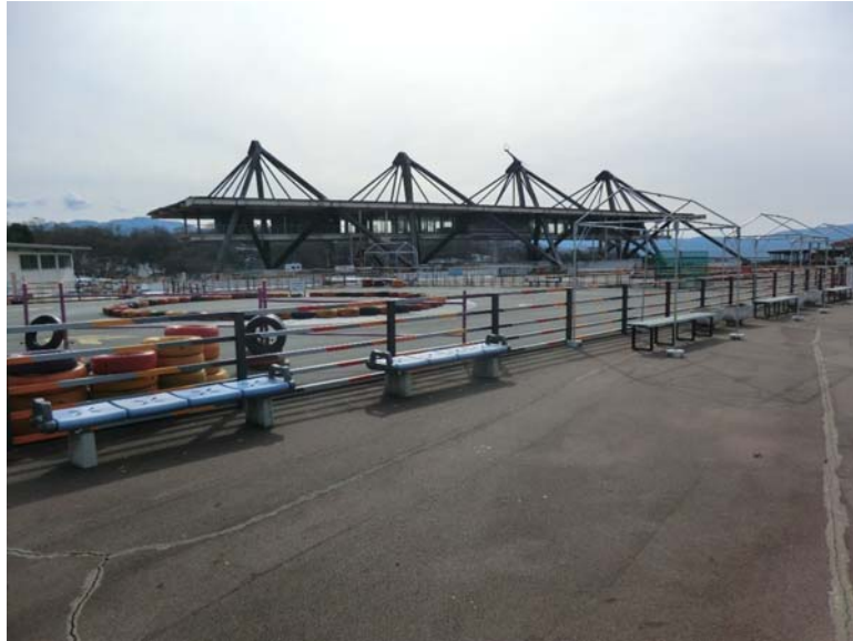
写真1.3-6 仮設施設の配置を検討する敷地内オープンスペースの例
